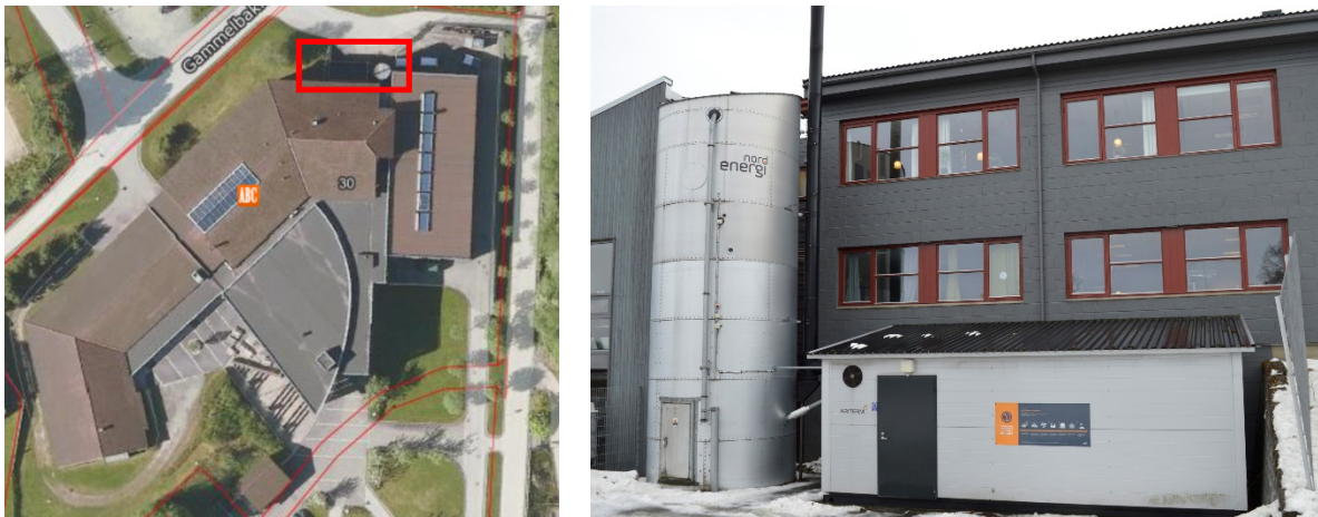
Figur 3. Plassering av pelletssiloen nord for skolebygget innenfor rød firkant (kilder: www.kart.finn.no og www.nordenergi.no ).
